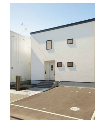
アスファルト舗装
